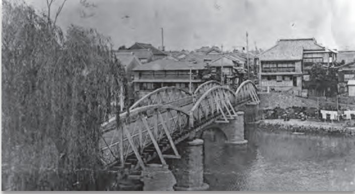
にだいめみなとばし めいじき 二代目湊橋 (明治期) 絵はがき「沼津名勝 湊橋ヨリ市街ヲ望ム」(蘭契社製) 橋・欄干部は木製で橋脚はレンガ造り
