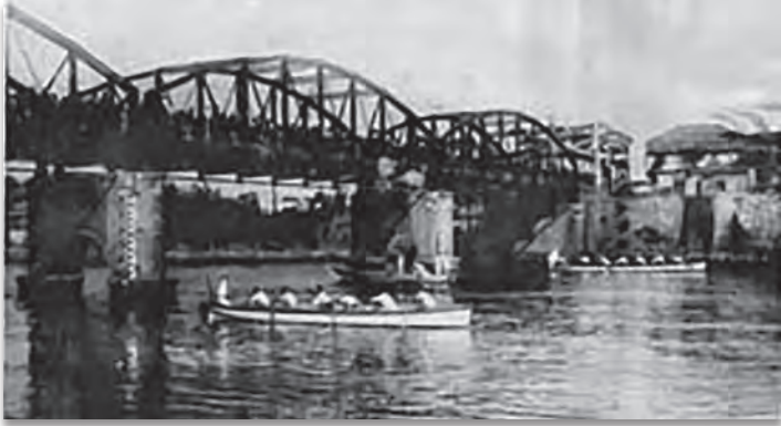
おなりばし 御成橋とボートレース (『沼津案内』大正8 (1919) 年) 三代目は御成橋と名を変え、橋・欄干・アーチ部は鉄製で橋脚はレンガ造り
