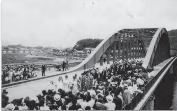
おなりばしわたりぞ 御成橋渡初め 昭和12 (1937) 年に現在の御成橋が完成 橋・欄干・アーチ部は鉄製で橋脚はコンクリート造り
